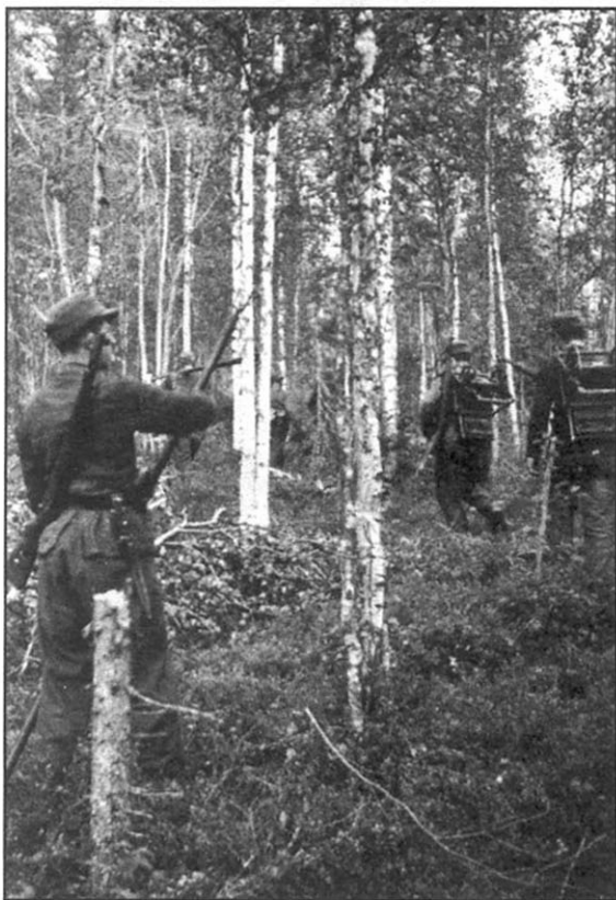
Связисты прокладывают телефонный провод в лесу Карелии, Восточный фронт, 1942 г. Солдаты справа на плечах несут катушки с кабелем, солдат слева - шест для размещения провода на деревьях.
