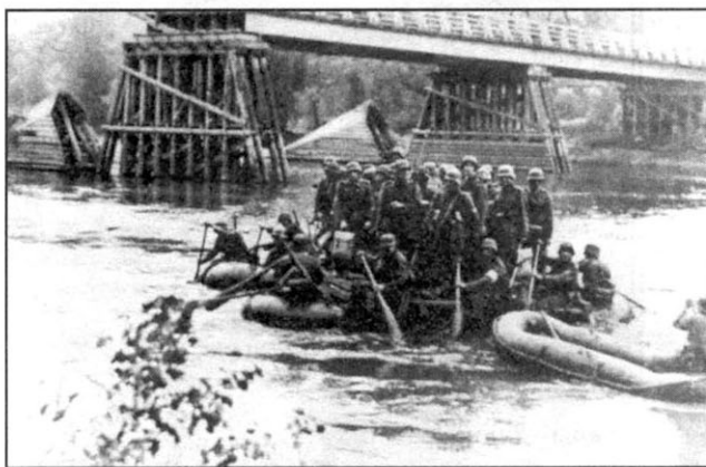
Для переправы саперного взвода используется паром, составленный из малых надувных лодок
