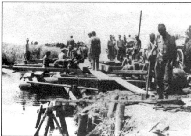
Идет строительство временного моста с использованием больших резиновых лодок.
