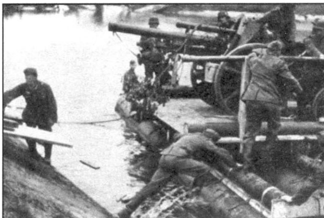
Паром, составленный из больших резиновых лодок перевозит 105-мм гаубицу. На заднем плане виден разрушенный мост.
