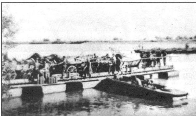
Понтонный паром полностью загружен и готов к отправке. На заднем плане - возвращающийся пустой паром.
